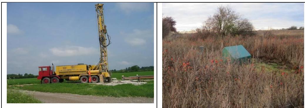
Figur 4.2. Boringen foretages med mobil borerig som er ca. 1 uge om at etablere boringen. Efter afslutning af boring etableres lille bygning der fremover beskytter borerøret og rummer en råvandsbeholder. Et eksempel på udformning af en sådan bygning ses til højre.
